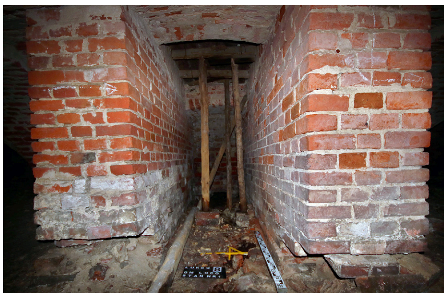
Ryc. 23. Łuków, pow. łukowski, woj. lubelskie. Dobudowane ściany w środkowej komnacie zachodniej części krypty, pomiędzy nimi drewniane pale podtrzymujące strop krypty (fot. J. Michalik)
