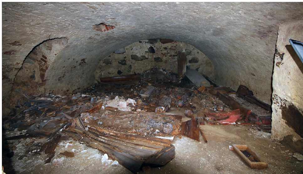
Ryc. 6. Piaseczno, pow. tczewski, woj. pomorskie. Widok na kryptę pod kościołem pod wezwaniem Narodzenia NMP; stan przed przeprowadzeniem prac porządkowych (fot. D. Grupa)
