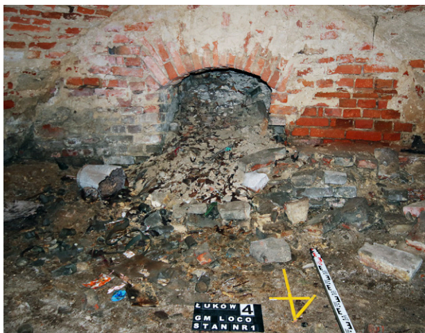
Ryc. 4. Łuków, pow. łukowski, woj. lubelskie. Otwór wentylacyjny nr 4 przed przeprowadzeniem prac porządkowych (fot. J. Michalik)
