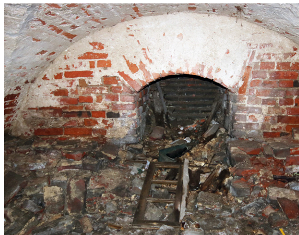
Ryc. 5. Łuków, pow. łukowski, woj. lubelskie. Otwór wentylacyjny nr 5 przed przeprowadzeniem prac porządkowych (fot. J. Michalik)
